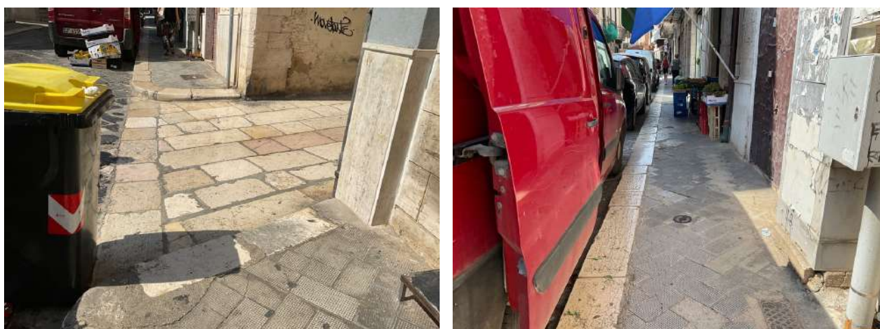
Figura 7 - Esempi di criticità riscontrate nella zona del centro storico
