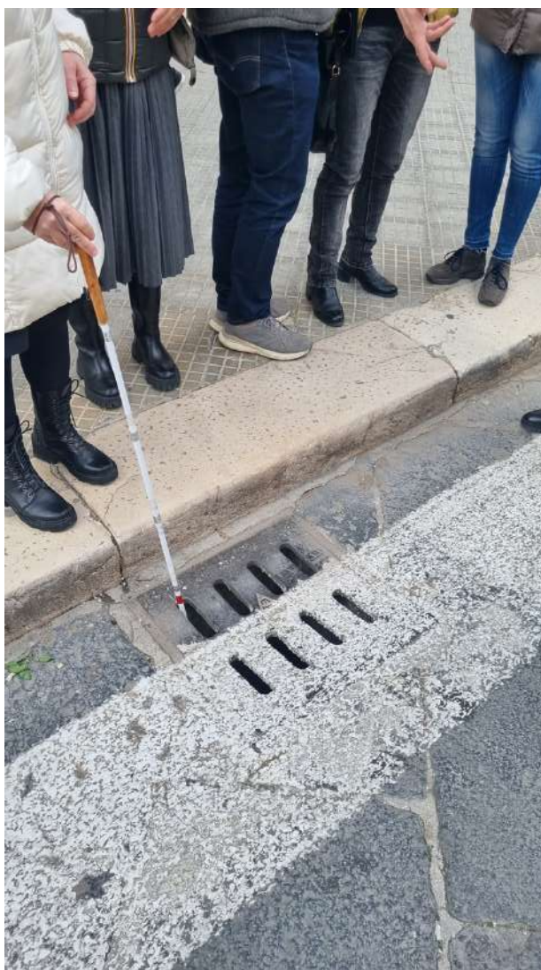
Figura 17 - Esempio di caditoia e criticità connessa
