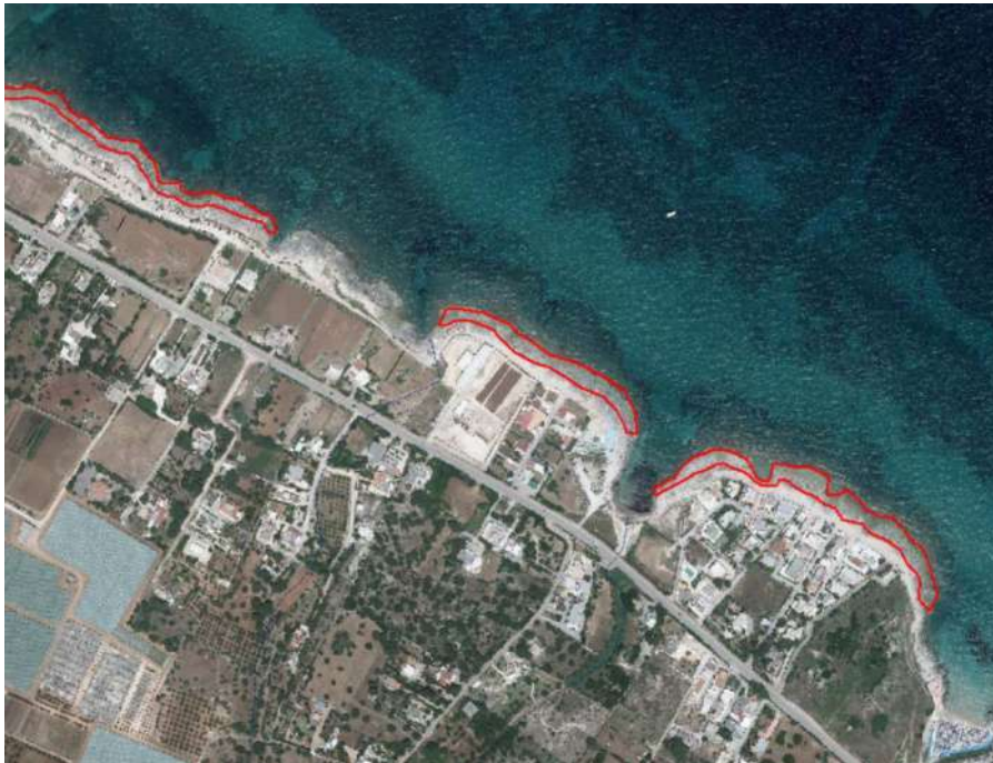
Dettaglio in località Cozze
